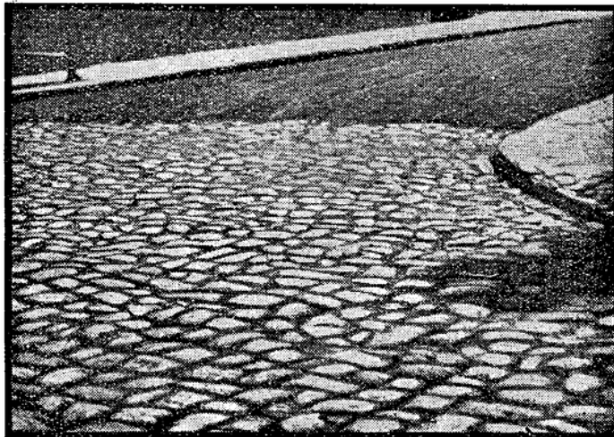
Abb. 1. Pflasterstraße. (Im Hintergrund Pflaster mit Ueberzug von Kaitasphalt)
