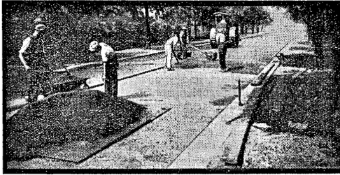
Abb. 5. Walzasphalt in Ausführung
