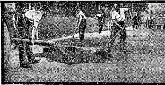
Abb. 6. Oberflächenbehandlung mit Kaltasphalt
